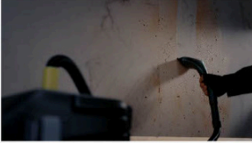
Dikey Yüzey Temizliği
